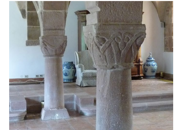
Vue actuelle des piliers et chapiteaux restaurés
