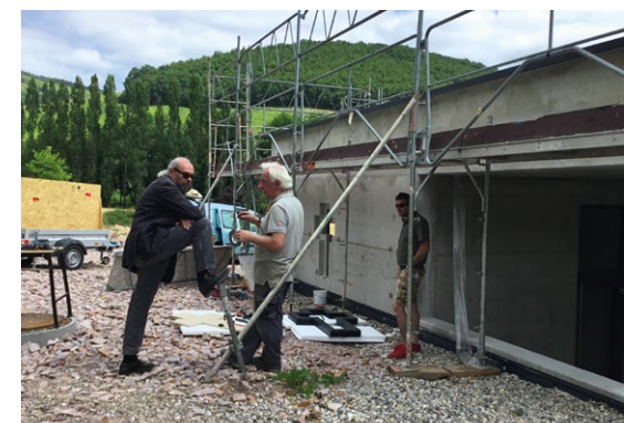
Chantier de l'extention
