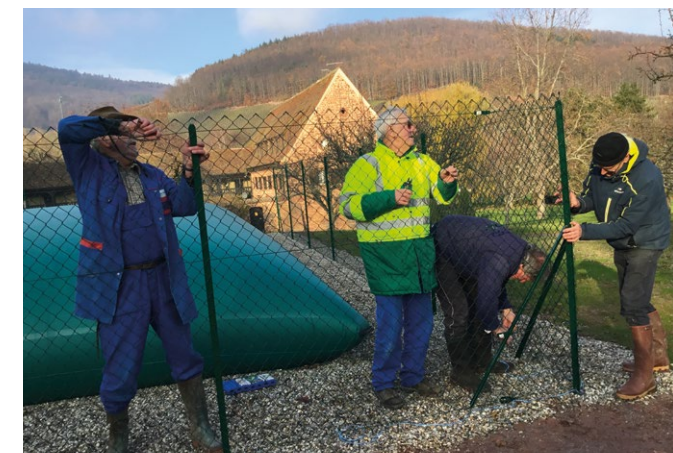
Montage de la clôture de la réserve incendie
